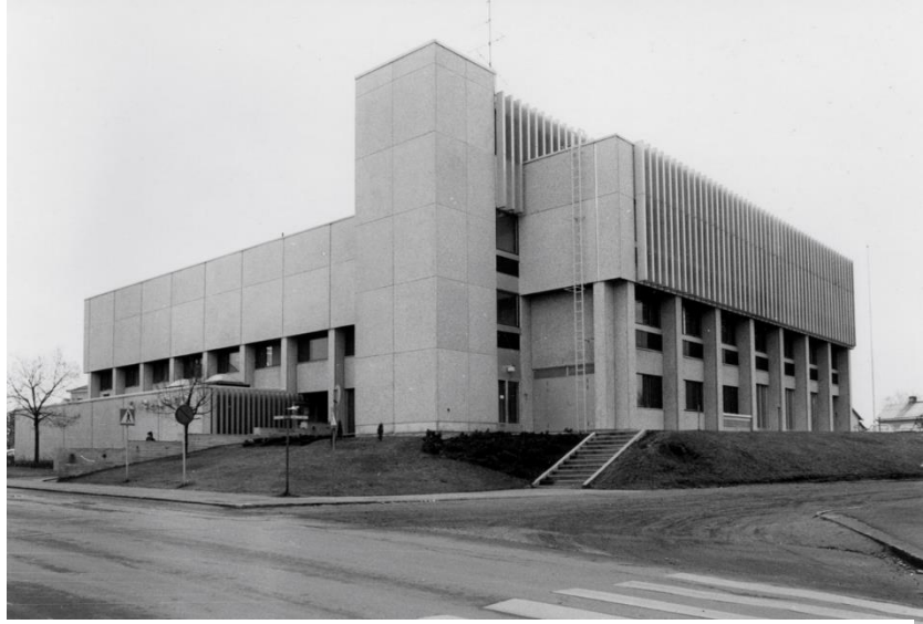
Kuva 13: Pääkirjaston julkisivut Valtakadulle 1970-luvun lopulla, jossa kerroksellinen strukturalismi on vahvasti osana arkkitehtuuria. (Aarne Mikonsaari 1974-1979, Lpr museot)
